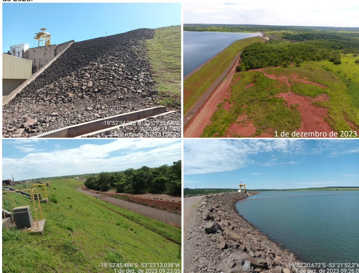
Figura 9 – Talude da PCH Verde 4A, evidenciando área cascalhada e gramada. Campanha de maio de 2023.
